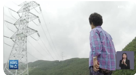
▲ 대규모 송전탑 설치
